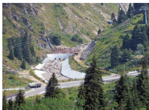
Рис. 11. Грунтовая дорога справа от русла р. Сарысай выше бетонной плотины.
