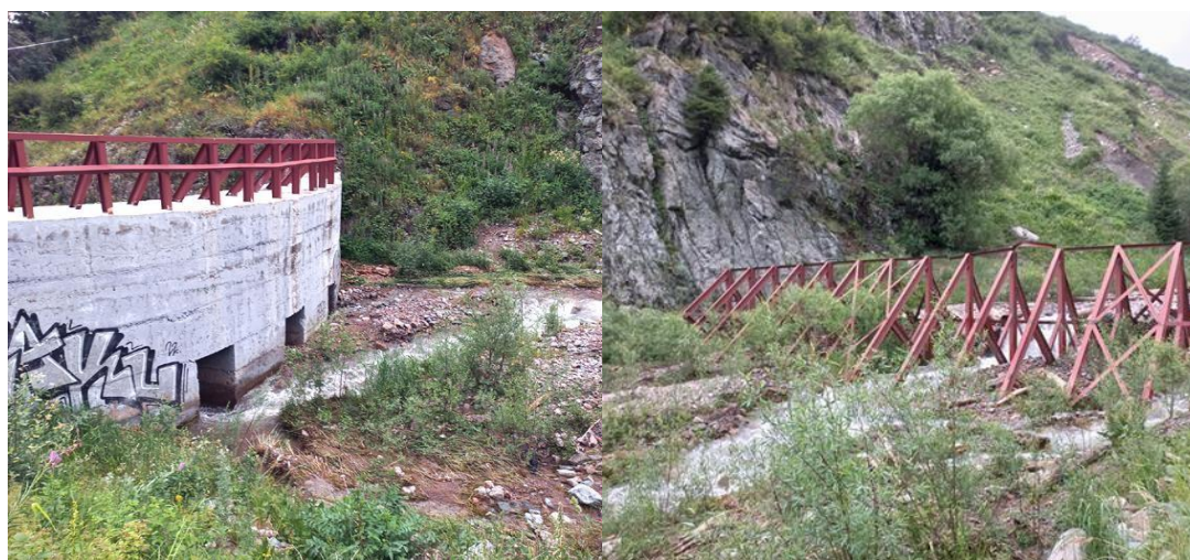
Рис. 9. Железобетонная плотина с металлическим сквозным сооружением на гребне.
